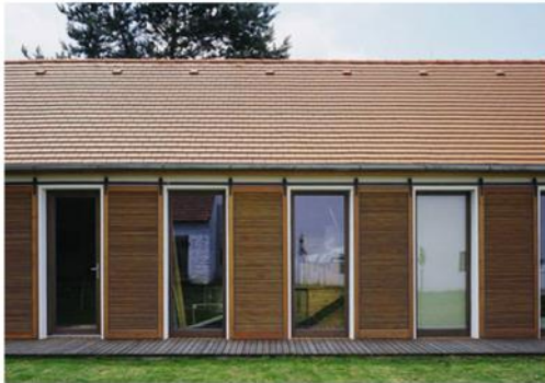
Abb. 26: Referenz Zubau - Neubau Streckhof
