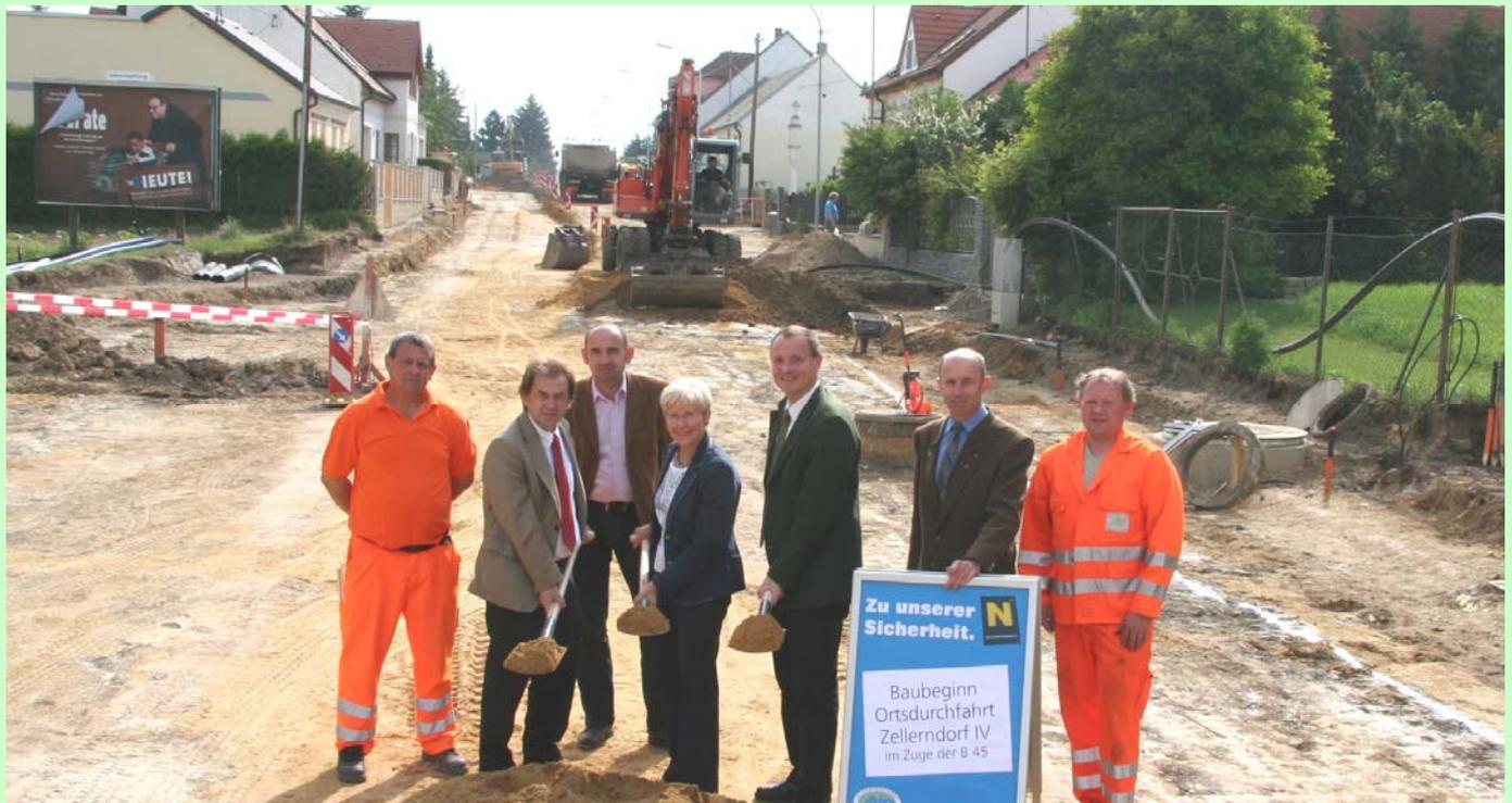
Die Bauarbeiten für die Neugestaltung des noch fehlenden Abschnittes der B 45 vom Bahnübergang Zellerndorf bis Watzelsdorf sind voll im Gang und sollten größtenteils bis Ende August abgeschlossen sein. Nach Verlegung der Einbauten (Kanal, Strom und Beleuchtung) werden nun neben der Erneuerung der Fahrbahn auch sämtliche Nebenflächen neu gestaltet. Baukosten: ca. €550.000,--.
